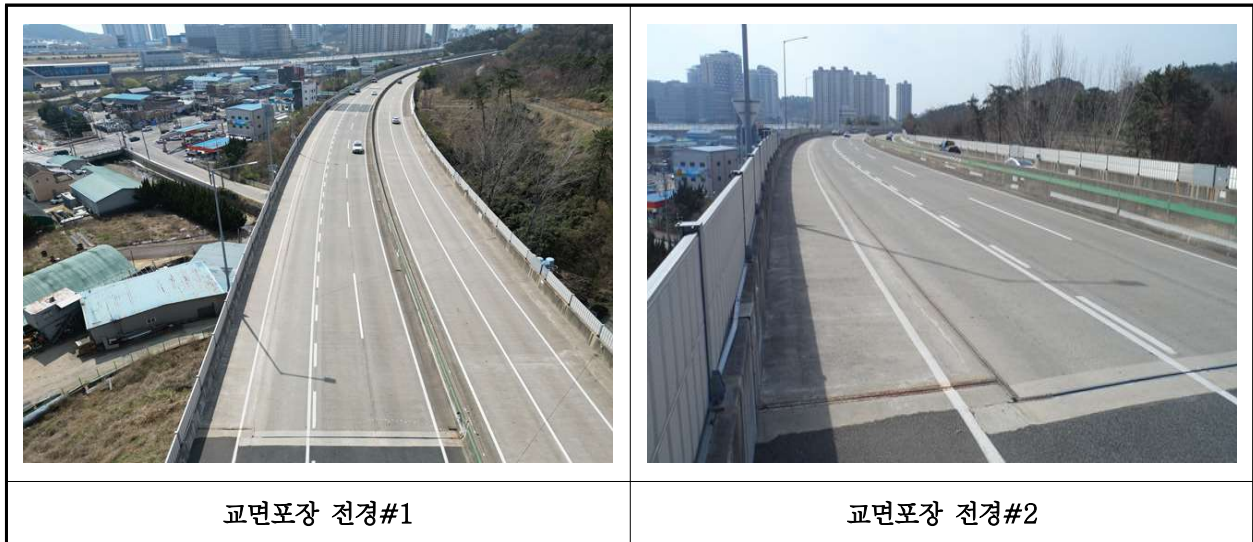
【사진 12.3.20】 교면포장 전경
