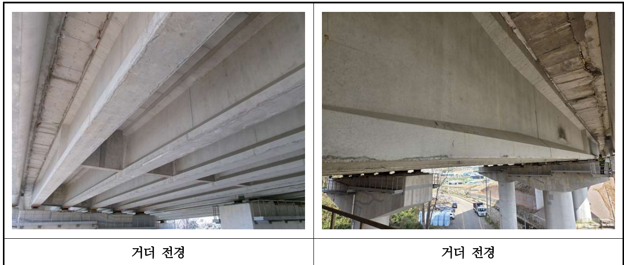
【사진 12.3.4】 거더 전경
