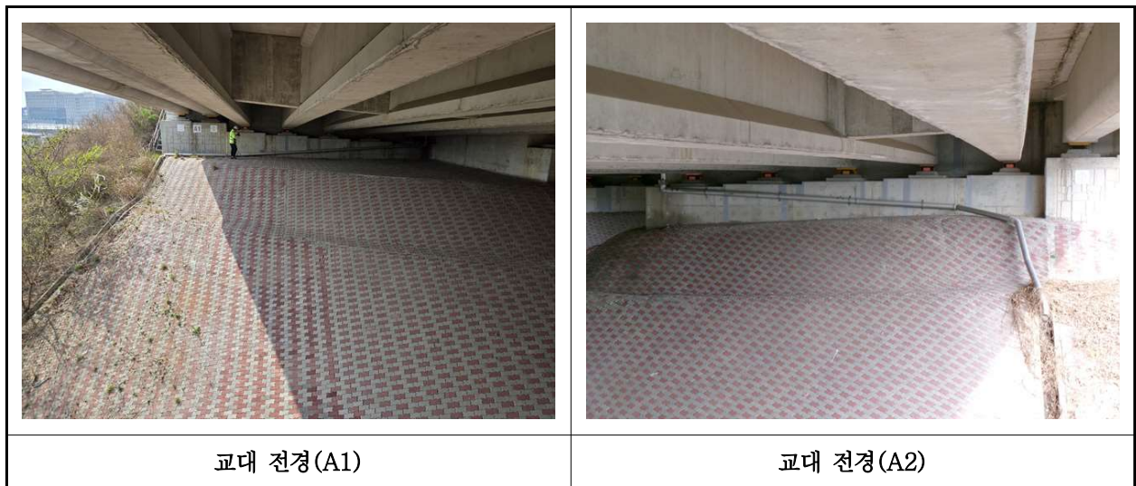
【사진 12.3.8】 교대 전경
