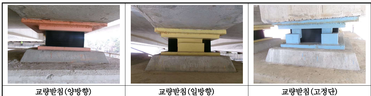
【사진 12.3.13】 교량받침 전경
