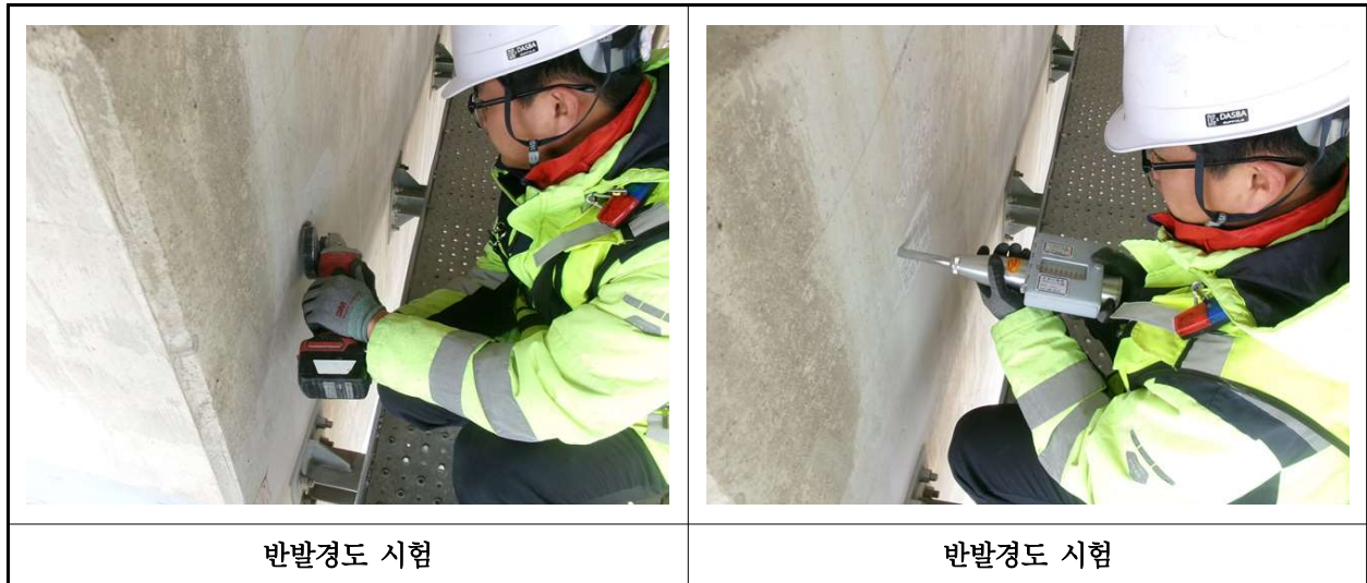
【사진 12.4.2】 반발경도시험 현장사진
