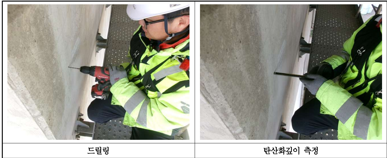
【사진 12.4.3】 탄산화 깊이 측정 현장사진
