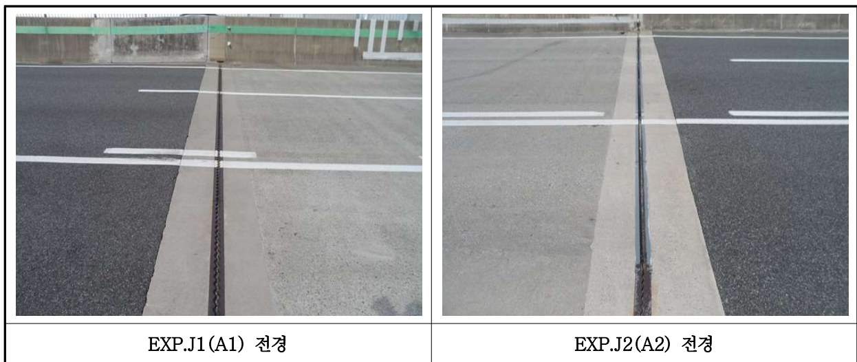
【사진 12.3.17】 신축이음장치 전경
