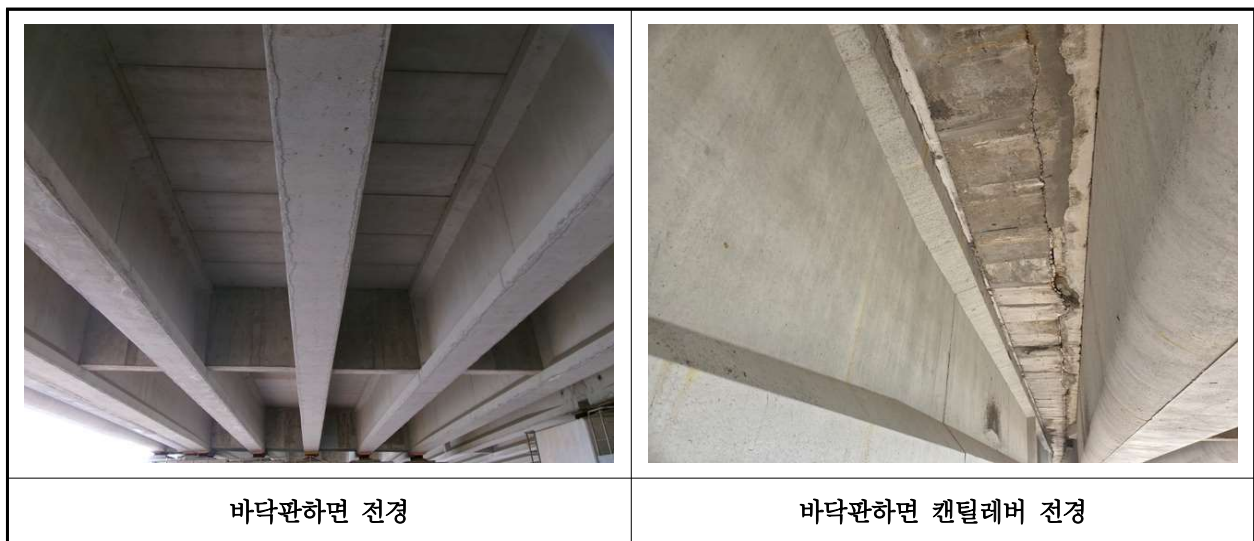
【사진 12.3.2】 바닥판하면 전경
