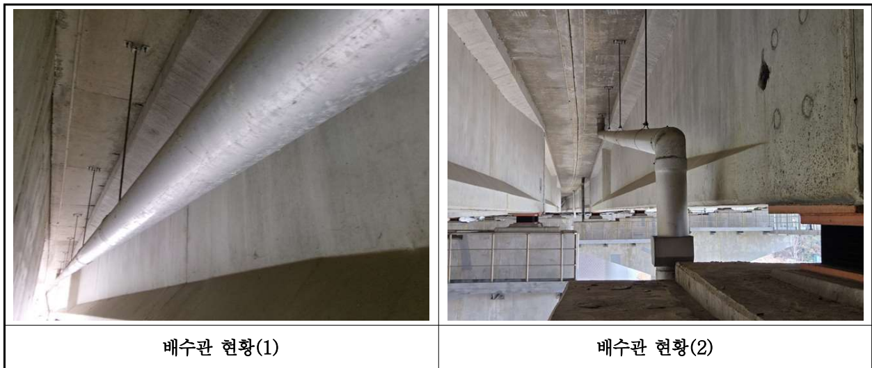
【사진 12.3.22】 배수시설 전경
