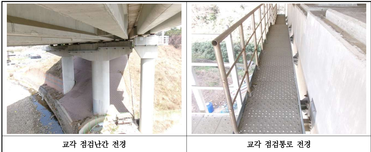
【사진 12.3.26】 교량 점검시설 전경
