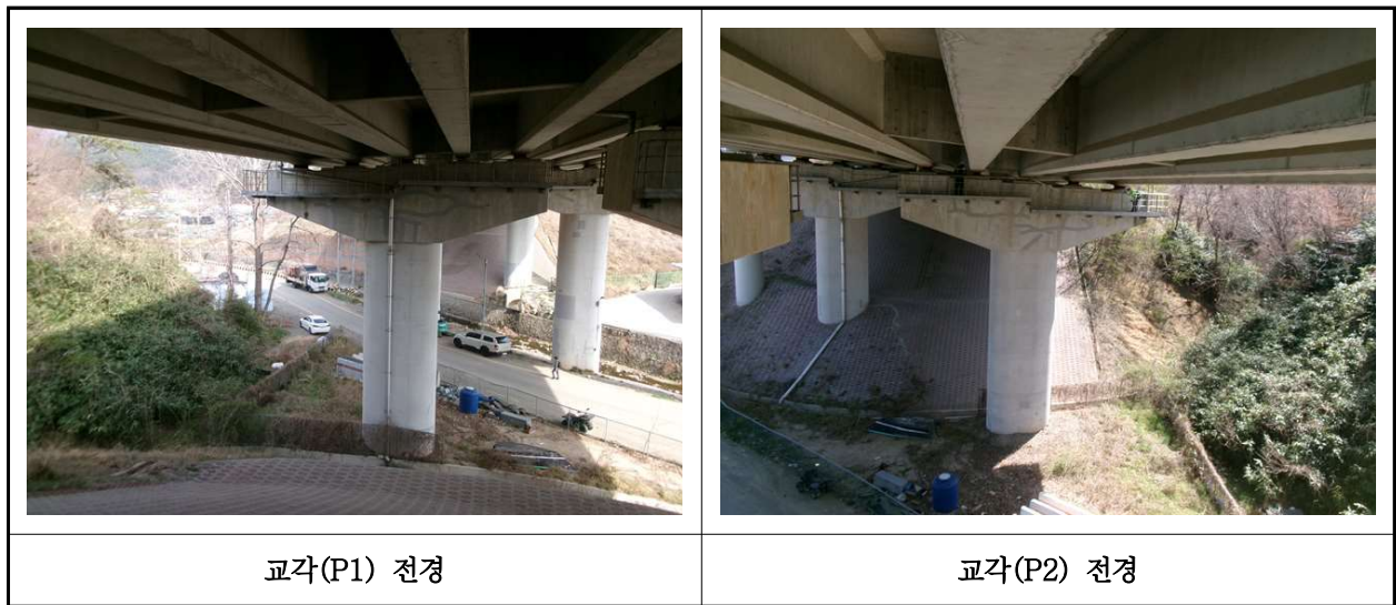
【사진 12.3.10】 교각 전경
