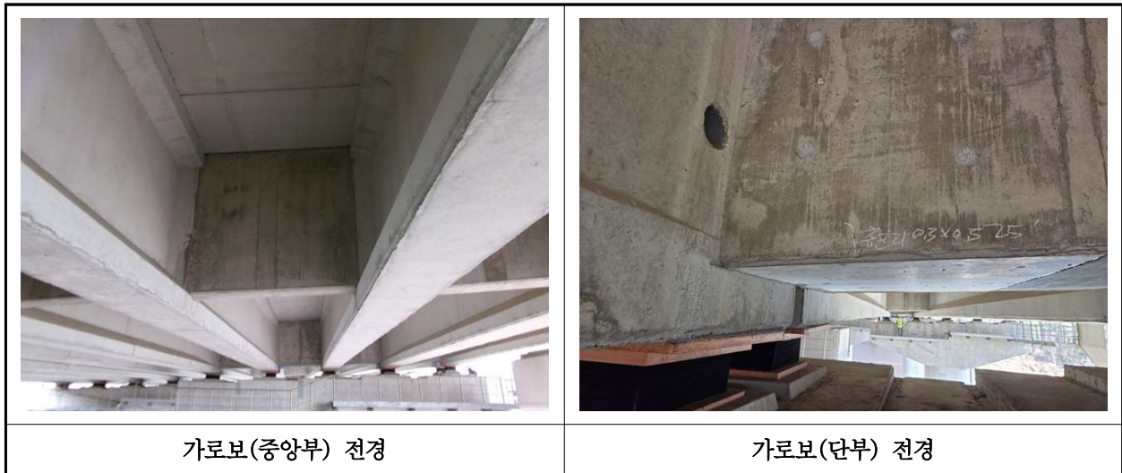
【사진 12.3.6】 가로보 전경
